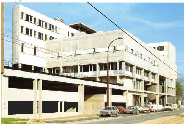
Photo 5 - Pour la Direction Informatique de la Trésorerie générale de Grenoble, la technologie du béton armé est utilisée afin de signifier à la fois la distribution programmatique, mais aussi le mode de construction.
