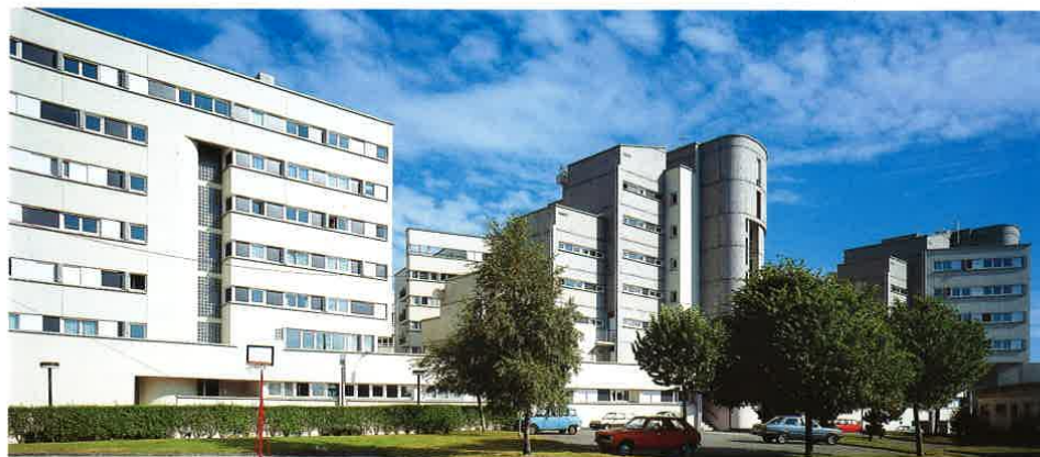
Photos 11 et 12 - A Brest, logements sociaux et bureaux de l'office HLM s'organisent autour d'espaces urbains différenciés, en accentuant l'effet de citadelle.
