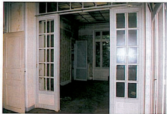
L'ancienne verrière côté jardin avant travaux procurait peu de lumière. Elle a été abattue au profit d'un patio verdoyant.
