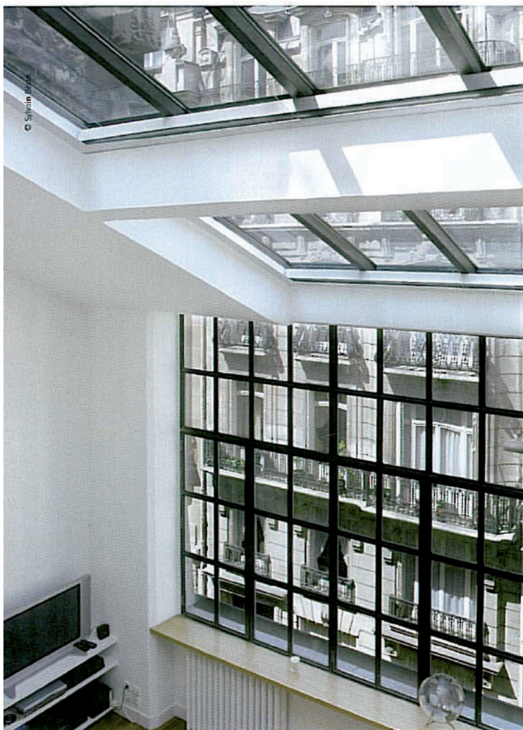
Pour la verrière zénithale, de nouvelles menuiseries en aluminium assurent une meilleure étanchéité et isolation thermique.
