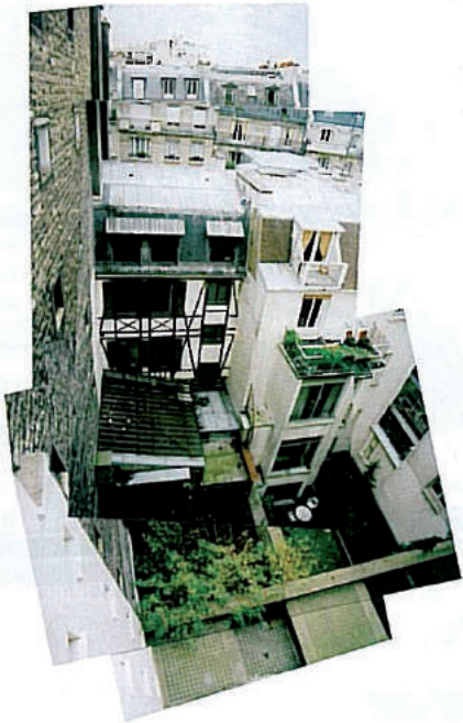
La façade côté jardin avant les travaux.
