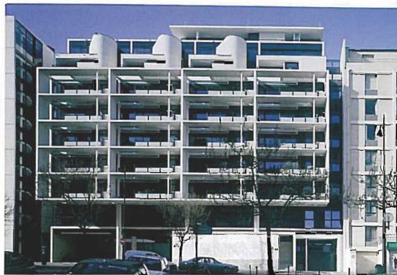
Logements, rue de l'Amiral-Mouchez, Paris XIV e , 2000, contrepoint.
